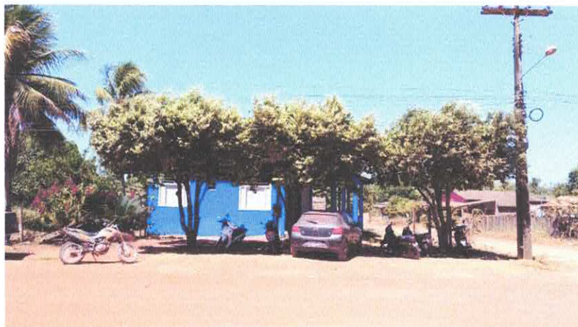
Imagem 1 - Vista Frontal, Fachada
