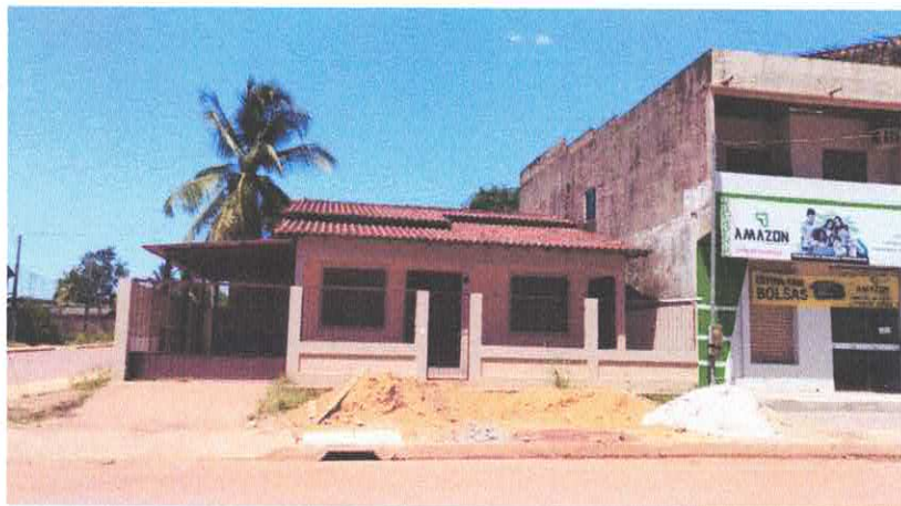
Imagem 02 – Casa 04, localizada na Av. 12 de Fevereiro, Centro.
